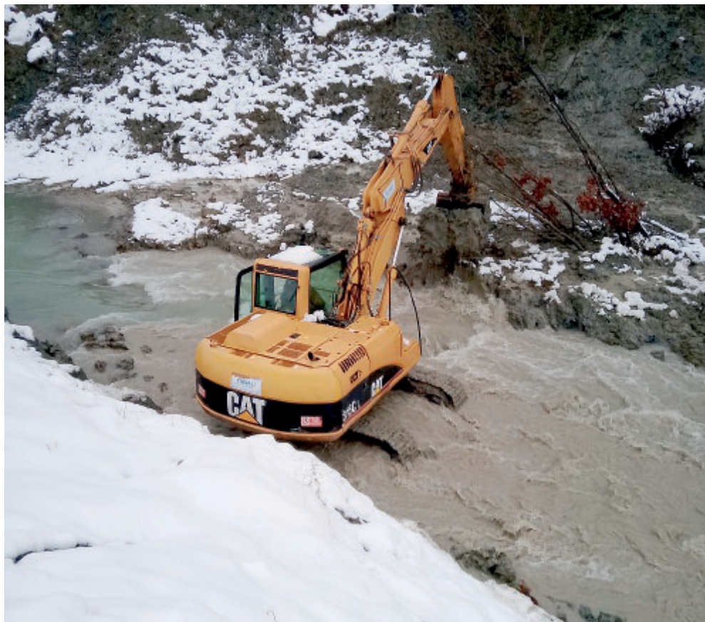
VACCAREZZA Stanno proseguendo a ritmo serrato i lavori per ripristinare l'alveo del torrente Baganza dalla strozzatura che si è formata a causa di una frana
